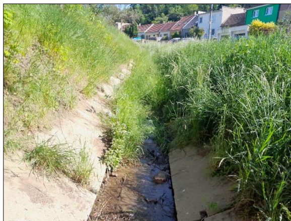
Břehy i dno toku jsou dnes nevhodně opevněny panely
